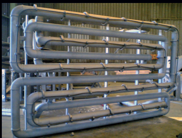
水冷系统铜构件浇筑前预铺设传感器
