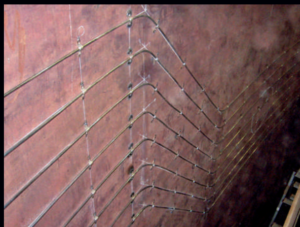
OPTISAVE铺设在水冷埋弧炉内
